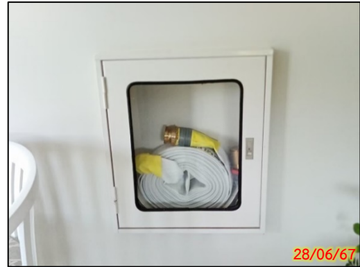
รูปที่ 2.2-8 สายส่งน้ำดับเพลิงภายในโครงการ
