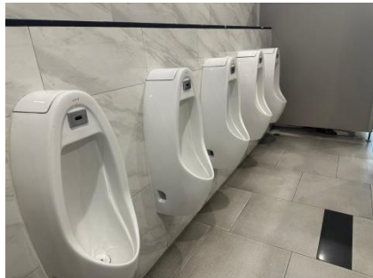
สุขภัณฑ์ที่ประหยัดน้ำ หรืออุปกรณ์ที่มีประสิทธิภาพสูง รูปที่ 2.1-7 ระบบน้ำใช้ของโครงการ
