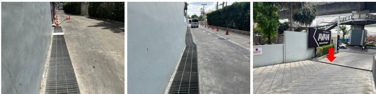
รูปที่ 2.1-9 ระบบระบายน้ำโครงการ
