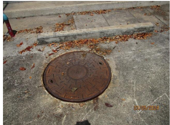
บ่อพักน้ำก่อนเข้าระบบบำบัด
