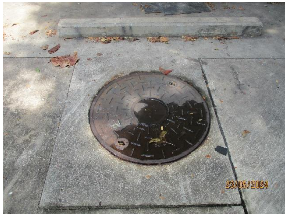
บ่อพักน้ำก่อนเข้าระบบบำบัด
