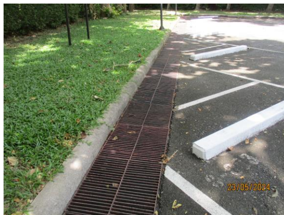
รูปที่ 3.1-28 รางระบายน้ำภายในโครงการ
