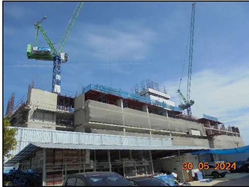
รูปที่ 93 โครงเหล็กโดยรอบตัวอาคาร และปิดช่องว่างด้วยผ้าใบทึบ
