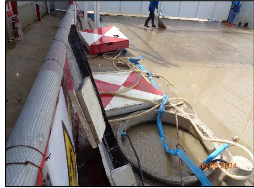
รูปที่ 38 ปอดักตะกอนดิน
