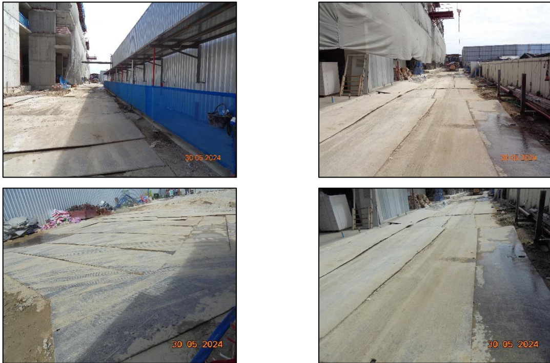
รูปที่ 21 แผ่นเหล็กปูบริเวณภายในพื้นที่โครงการที่รถวิ่งผ่าน
