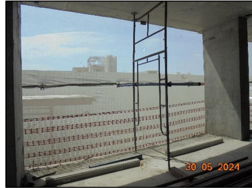
รูปที่ 93 โครงเหล็กโดยรอบตัวอาคาร และปิดช่องว่างด้วยผ้าใบทึบ
