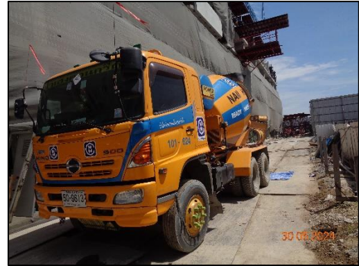
รูปที่ 13 การใช้คอนกรีตที่หล่อมาจากข้างนอกโครงการ
