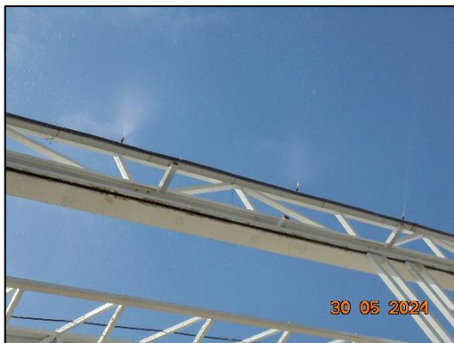
รูปที่ 9 การฉีดพรมน้ำบริเวณพื้นที่ก่อสร้าง และการติดตั้งหัวฉีดพ่นละอองน้ำ
