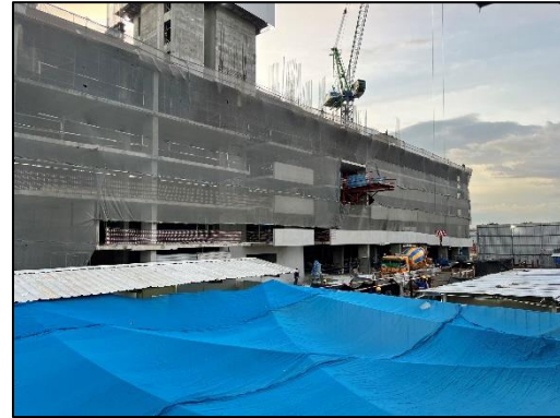
รูปที่ 5 การติดตั้ง Mesh Sheet
