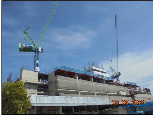
รูปที่ 5 การติดตั้ง Mesh Sheet
