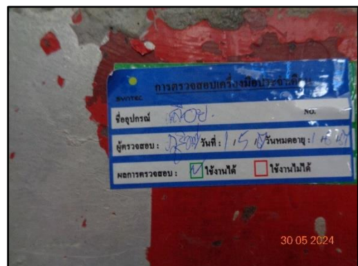
รูปที่ 70 การตรวจสอบความพร้อมของอุปกรณ์แล้วติดฉลากที่อุปกรณ์ว่าอนุมัติให้ใช้งาน
