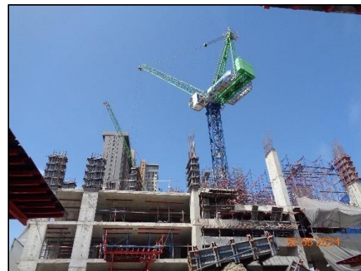
รูปที่ 57 การควบคุมแขนของเครนให้อยู่เฉพาะภายในพื้นที่โครงการ
