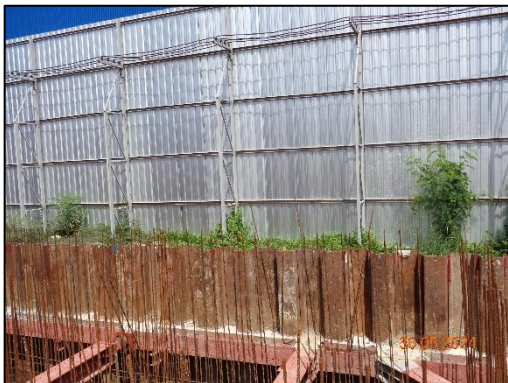
รูปที่ 30 ระบบป้องกันการพังทลายของดิน
