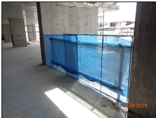
รูปที่ 98 ที่กั้นเพื่อป้องกันเศษวัสดุร่วงหล่น
