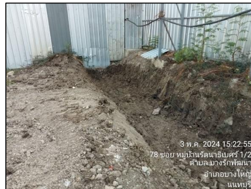
รูปที่ 37 รางระบายน้ำชั่วคราวล้อมรอบบริเวณพื้นที่โครงการ
