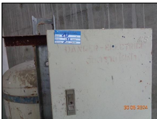
รูปที่ 70 การตรวจสอบความพร้อมของอุปกรณ์แล้วติดฉลากที่อุปกรณ์ว่าอนุมัติให้ใช้งาน
