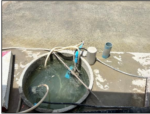
รูปที่ 38 ปอดักตะกอนดิน
