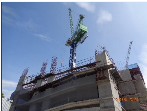
รูปที่ 57 การควบคุมแขนของเครนให้อยู่เฉพาะภายในพื้นที่โครงการ
