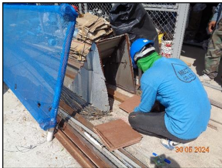
รูปที่ 11 การตัด หรือเจียร ทำในพื้นในที่ที่คลุมผ้าใบ และผนังปิดด้านข้าง 3 ด้าน
