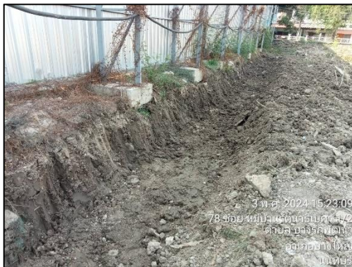
รูปที่ 37 รางระบายน้ำชั่วคราวล้อมรอบบริเวณพื้นที่โครงการ
