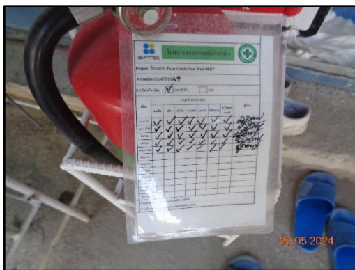
รูปที่ 67 การตรวจสอบสภาพของถังเคมีดับเพลิง
