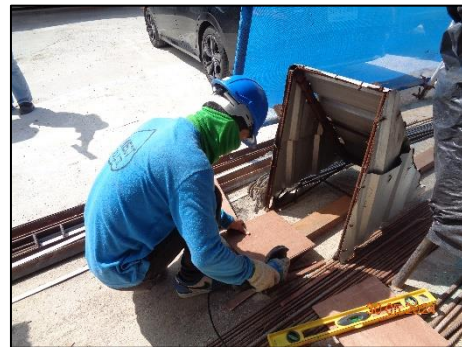
รูปที่ 11 การตัด หรือเจียร ทำในพื้นในที่ที่คลุมผ้าใบ และผนังปิดด้านข้าง 3 ด้าน
