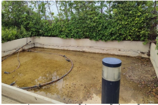
ภาพที่ 3-42 แก้ไขปัญหา น้ำรั่วซึมจากพื้นที่สีเขียวชั้นดาดฟ้า อยู่ระหว่างปรับปรุงเป็นหญ้าเทียม และยาแนวปิดรอยรั่วซึม
