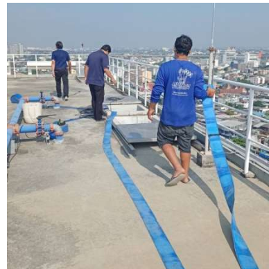
ภาพที่ 3-27 ล้างถังสำรองน้ำใช้
