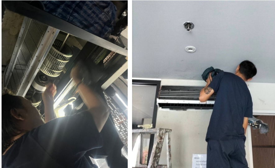
ภาพที่ 3-29 ล้างเครื่องปรับอากาศภายในอาคาร
