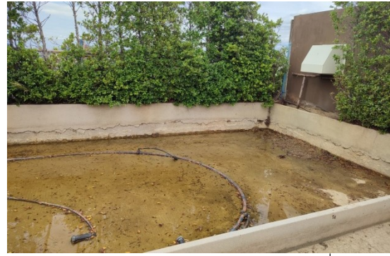
ภาพที่ 3-42 แก้ไขปัญหา น้ำรั่วซึมจากพื้นที่สีเขียวชั้นดาดฟ้า อยู่ระหว่างปรับปรุงเป็นหญ้าเทียม และยาแนวปิดรอยรั่วซึม
