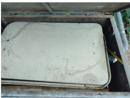
ภาพที่ 4-35 ตักไขมันที่ติดดักไขมันจากน้ำทิ้งห้องครัว
