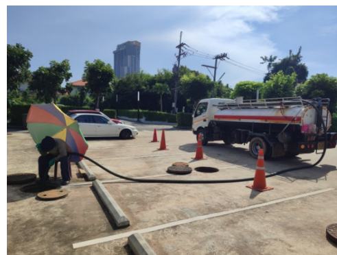
ภาพที่ 4-9 ระบบบำบัดน้ำเสีย บำรุงรักษาระบบบำบัดน้ำเสียและสูบน้ำจากบ่อเก็บตะกอน
