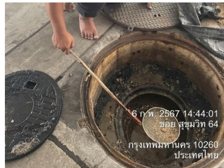
เจ้าหน้าที่ตัดกากตะกอนไขมันระบบบำบัดน้ำเสีย
