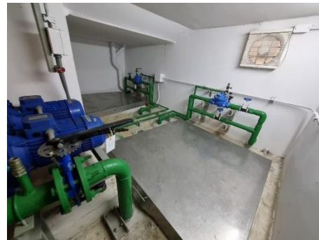
ถังเก็บน้ำใต้ดินและระบบปั๊มน้ำใช้
