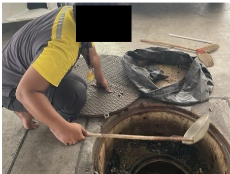
เจ้าหน้าที่ตัดกากตะกอนไขมันระบบบำบัดน้ำเสีย
