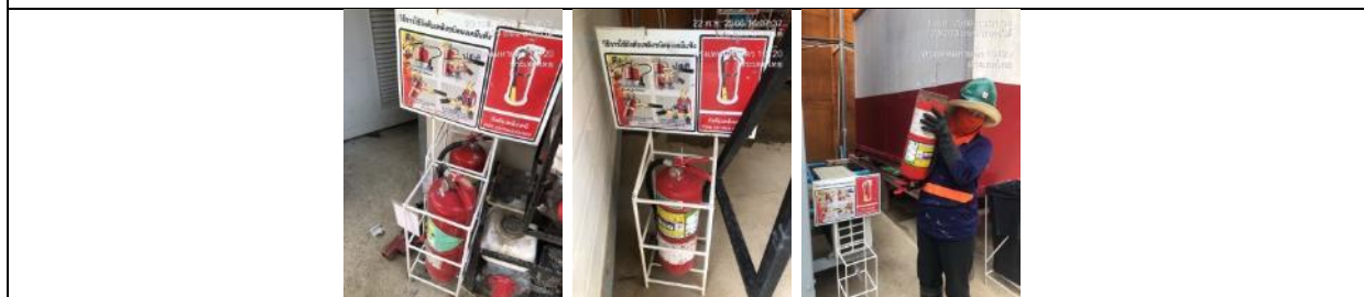
รูปที่ ๗7.35 ถังดับเพลิงเคมี ป้ายแนะนำการใช้ถังดับเพลิง พร้อมทั้งทำการตรวจถังดับเพลิง
