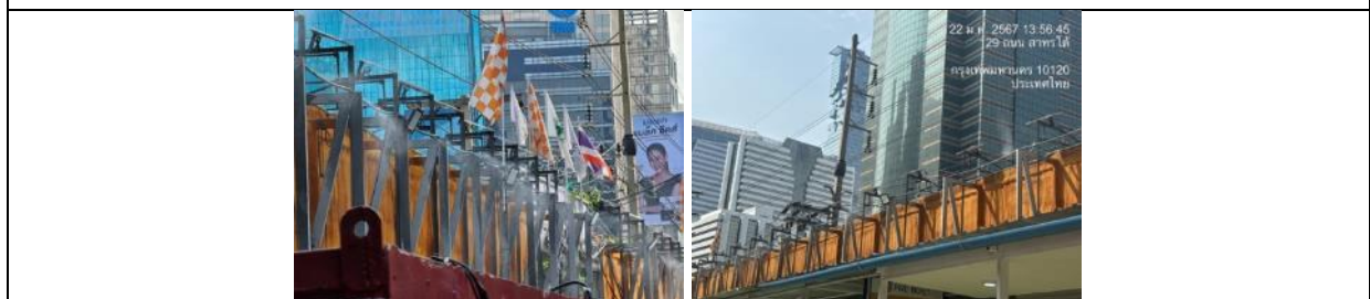
รูปที่ ๗.๑๐ ระบบพ่นละอองสเปรย์น้ำกันฝุ่น
