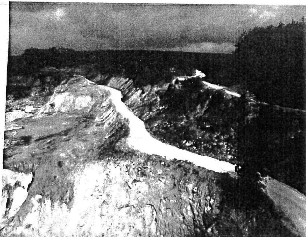
ภาพที่ 4 จุดถมดินทำขึ้นบันไดป้องกันการพังทลายขอบบ่อด้านทิศตะวันตก
