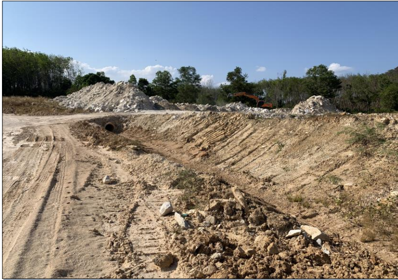
ภาพถ่ายที่ 2-4 สร้างคันทำนบระบายน้ำโดยรอบพื้นที่เก็บกองเปลือกดินและเศษหิน
