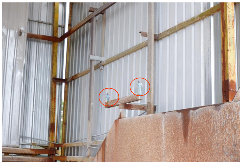
ภาพถ่ายที่ 2-6 โรงแต่งแร่มีการติดตั้งระบบสเปรย์น้ำจุดที่กำเนิดฝุ่นต่างๆ
