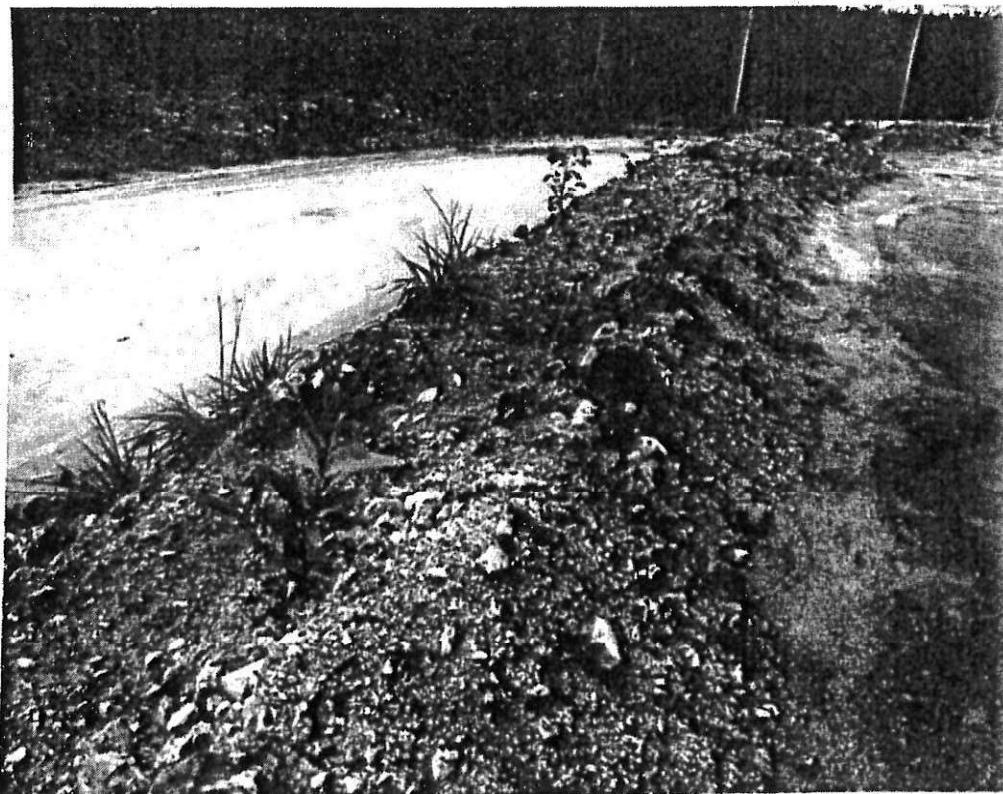
ภาพที่ 6 คันดินรอบเส้นทางขนส่งในพื้นที่โครงการ พร้อมปลูกต้นไม้ตลอดแนว
