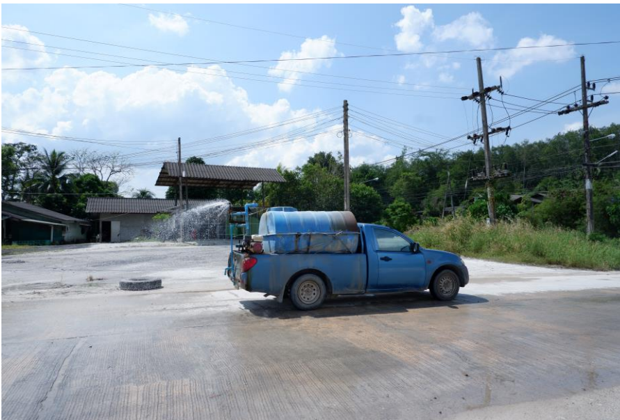
ภาพถ่ายที่ 2-8 ฉีดพรมน้ำเพื่อลดการฟุ้งกระจายของฝุ่นละออง
