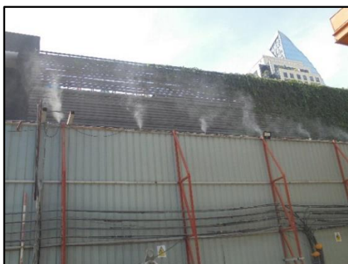
รูปที่ 3 ฉีดสปริงเกอร์และฉีดพรมน้ำบริเวณก่อสร้างหรือบริเวณที่ทำให้เกิดฝุ่น
