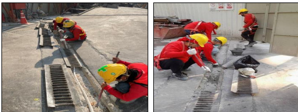
รูปที่ 37 เจ้าหน้าที่ดูแลขุดลอกตะกอนที่สะสมในท่อระบายน้ำชั่วคราว
