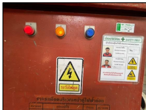
รูปที่ 49 ติดตั้งแผงควบคุมไฟฟ้าและเครื่องตัดกระแสไฟฟ้า
