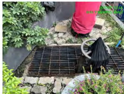
ภาพที่ 2-83 ฝาท่อระบายน้ำเป็นแบบฝาทะแกรงเหล็ก
