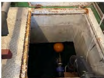
ภาพที่ 2-13 น้ำสำรองเก็บไว้ในถังเก็บน้ำใต้ดิน และถังเก็บน้ำชั้นดาดฟ้า
