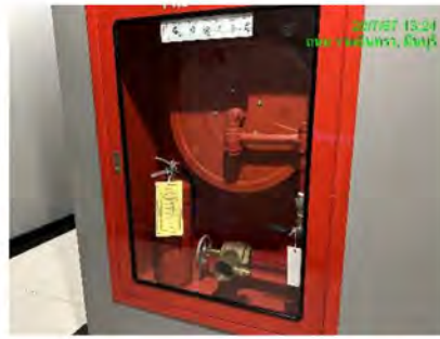
ภาพที่ 3-20 สายและตู้เก็บสายฉีดน้ำดับเพลิง อยู่ในสภาพพร้อมใช้งาน
