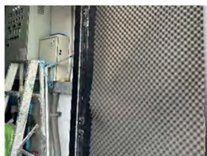
ภาพที่ 2-87 แผ่นดูดซับเสียงห้องเครื่อง สูบน้ำของส้วมลอยน้ำ
