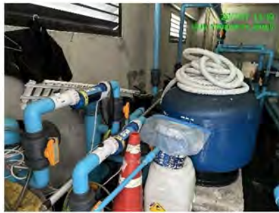
ภาพที่ 2-25 ระบบกรองน้ำของสระว่ายน้ำ ภาพที่ 2-26 การดูแลทำความสะอาด ล้างตะไคร่
