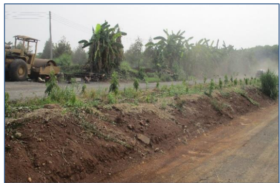
รูปที่ 2.1-8 คั่นทำนบดินตามขอบประทานบัตรโดยรอบพื้นที่โครงการ
