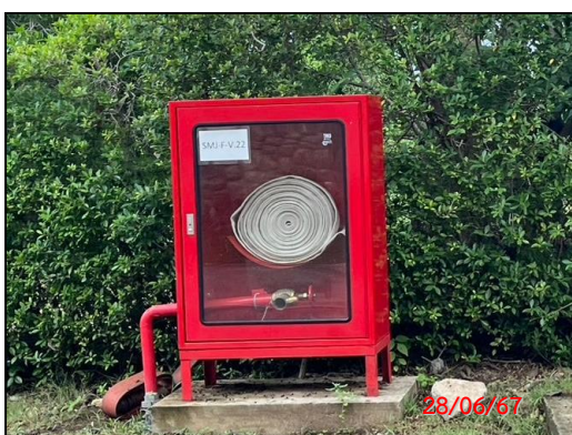
รูปที่ 2.2-5 ตู้ FHC ภายในโครงการ
