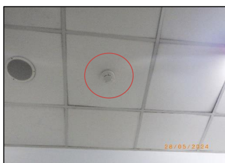
อุปกรณ์ตรวจจับควันและความร้อน
