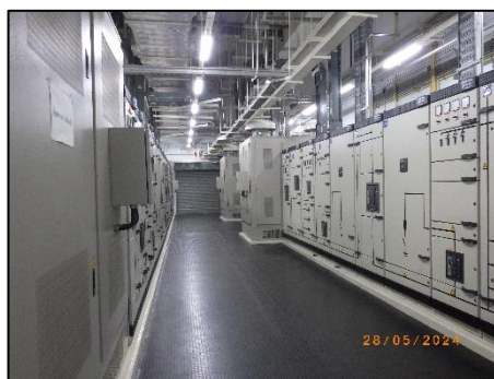
รูปที่ 2-21 การติดตั้งอุปกรณ์ปรับแรงดันไฟฟ้า
