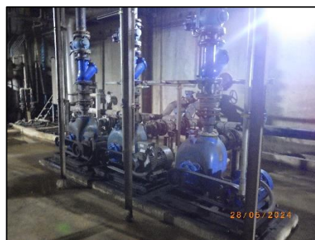
รูปที่ 2-13 ระบบบำบัดน้ำเสียขั้นต้น
