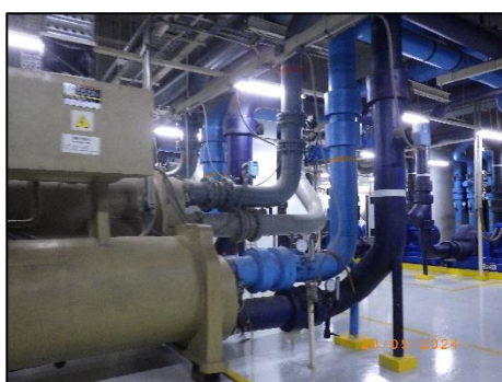
รูปที่ 2-18 เครื่องทำความเย็นชนิดระบายความร้อนด้วยน้ำแบบหอยโข่งและแบบสกรู
