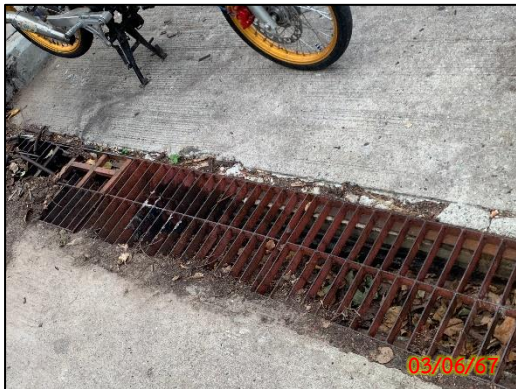
รูปที่ 2.2-3 ตะแกรงดักขยะภายในโครงการ
