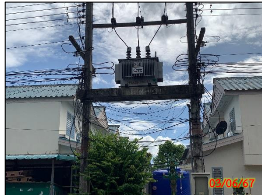
รูปที่ 2.2-12 หม้อแปลงไฟฟ้าภายในโครงการ
