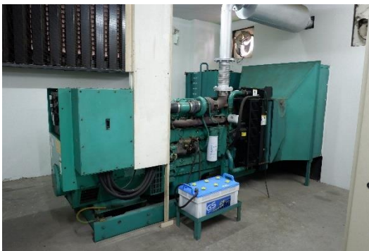
ภาพที่ 19 ระบบไฟฟ้าสำรองภายในโครงการ
