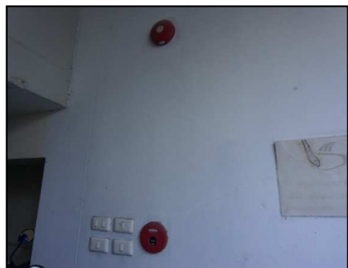
ภาพที่ 1-11 อุปกรณ์แจ้งสัญญาณเพลิงไหม้
