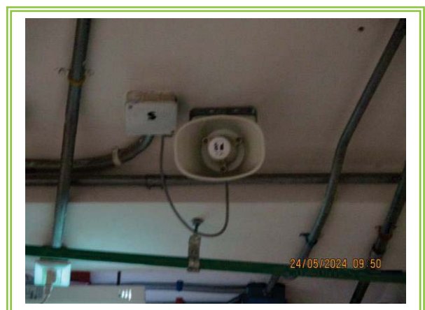
รูปที่ 3-48 ลำโพงแจ้งสัญญาณเตือนอัคคีภัย (Fire Alarm Speaker)
