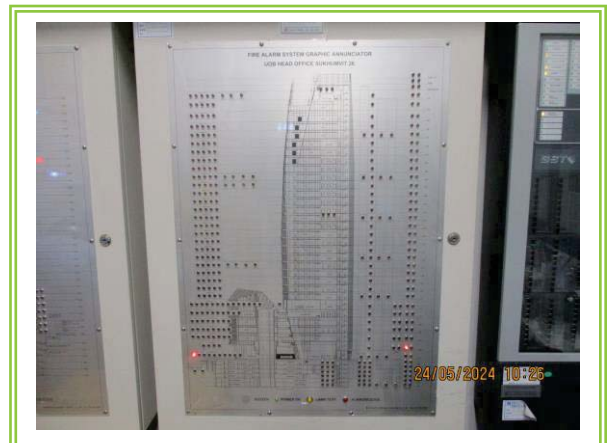
รูปที่ 3-46 แผงควบคุมระบบเตือนอัคคีภัย (Fire Alarm Control Panel : FCP)
