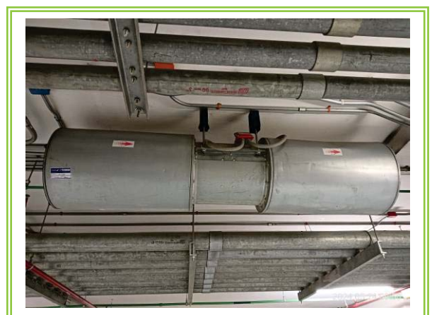
รูปที่ 3-6 พัฒนาระบายอากาศ บริเวณลานจอดรถชั้นใต้ดิน
