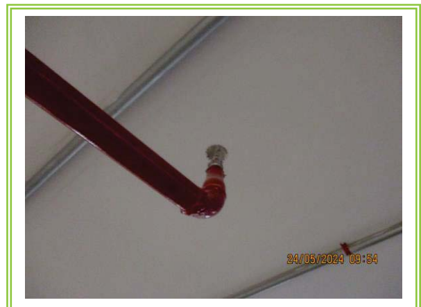
รูปที่ 3-44 หัวกระจายน้ำดับเพลิงอัตโนมัติ (Sprinkler System)
