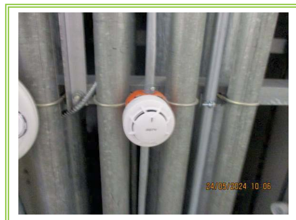
รูปที่ 3-47 เครื่องตรวจจับความร้อน (Heat Detector)
