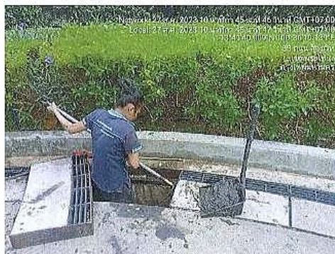
ภาพที่ 3-36 ขุดลอกท่อระบายน้ำและบ่อพักน้ำ
