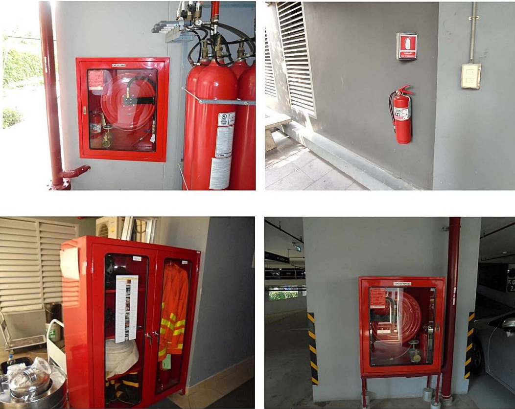
ภาพที่ 3-23 ท่อเย็น และตู้เก็บสายฉีดน้ำดับเพลิงและอุปกรณ์
