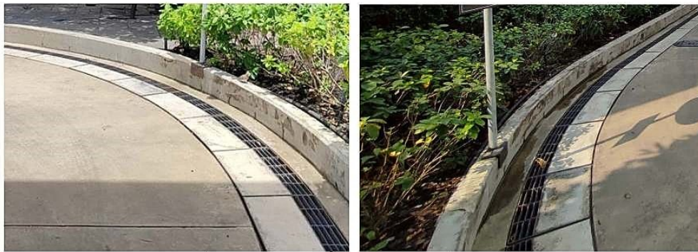
ภาพที่ 3-10 ระบบระบายน้ำของโครงการ ไม่มีเศษขยะอุดตัน
