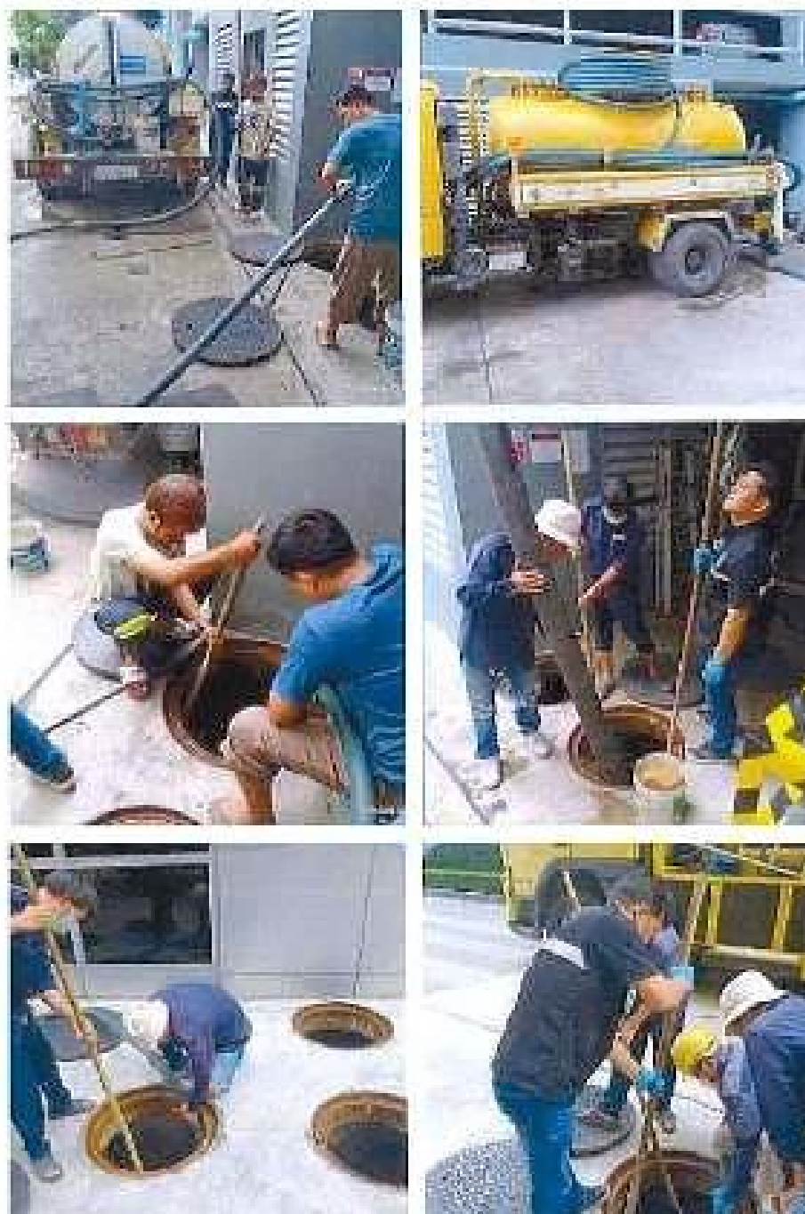
ภาพที่ 3.08 ขุดลอกและทำความสะอาดบ่อเก็บน้ำเสีย
