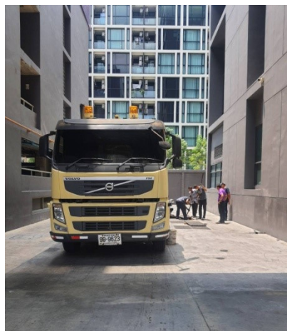
ภาพที่ 5-31 ดูดตะกอนที่บ่อเก็บตะกอนของระบบบำบัดน้ำเสีย
