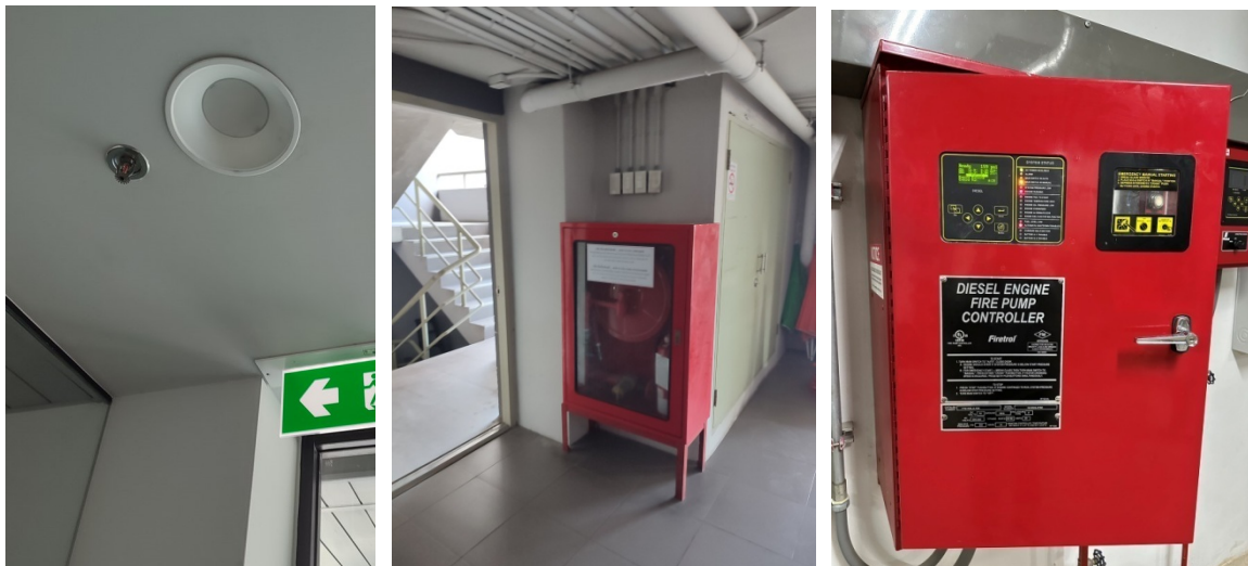
ภาพที่ 5-27 อุปกรณ์ดับเพลิง หัวกระจายน้ำดับเพลิงอัตโนมัติ ระบบท่อเย็นและตู้เก็บสายฉีดน้ำดับเพลิง
