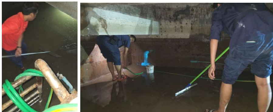
ภาพที่ 3-38 ล้างทำความสะอาดถึงสำรอน้ำใช้
