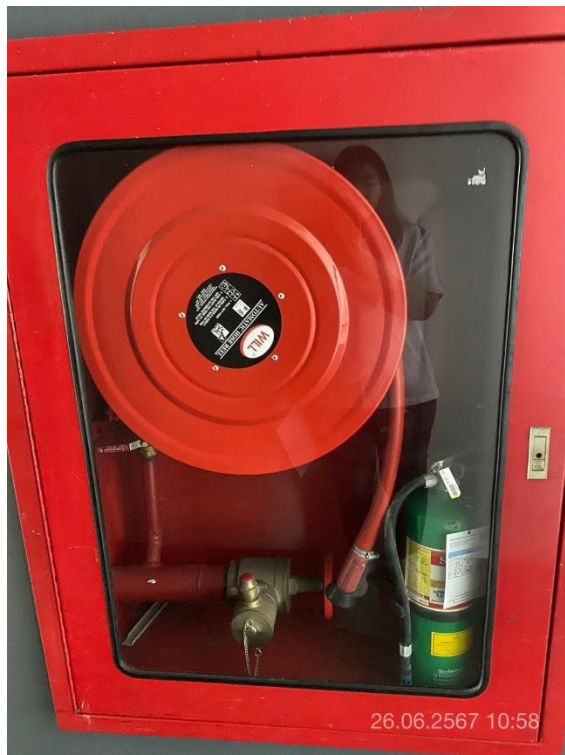
ภาพที่ 16 แสดงตู้เก็บอุปกรณ์ดับเพลิง
