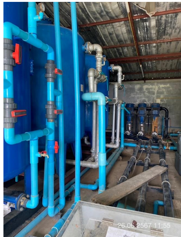
ภาพที่ 26 แสดงระบบเติมคลอรีนอัตโนมัติของระบบประปา
