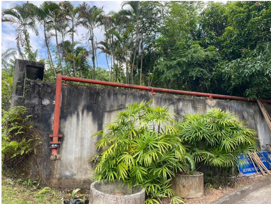
ภาพที่ 19 แสดงบ่อเก็บน้ำสำรองสำหรับดับเพลิง และหัวจ่ายน้ำดับเพลิง
