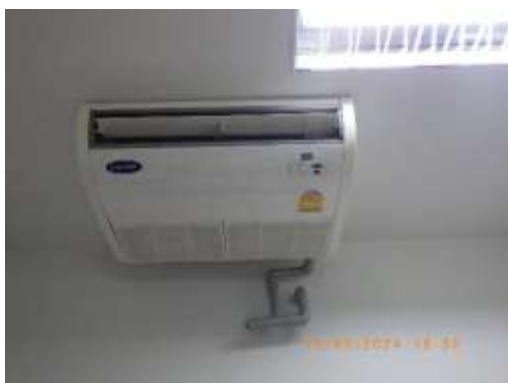
รูปที่ 2-4 เครื่องปรับอากาศประเภทไฟเบอร์ 5
