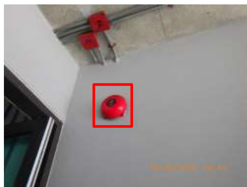
รูปที่ 2-52 Fire Alarm
