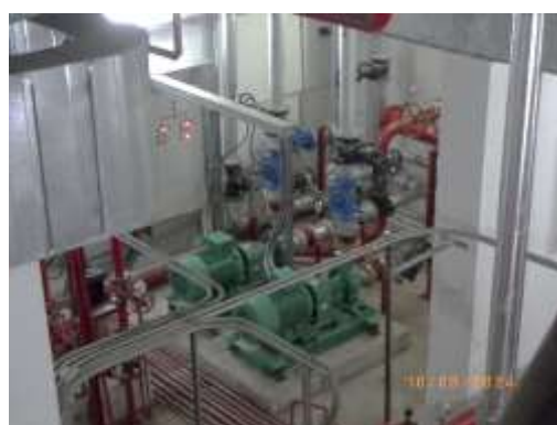
รูปที่ 2-53 Fire Pump System
