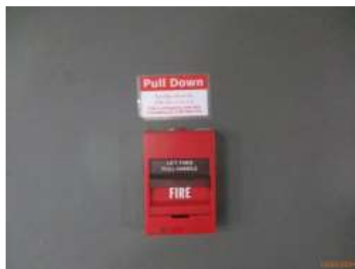
รูปที่ 2-50 Emergency Fire Button
