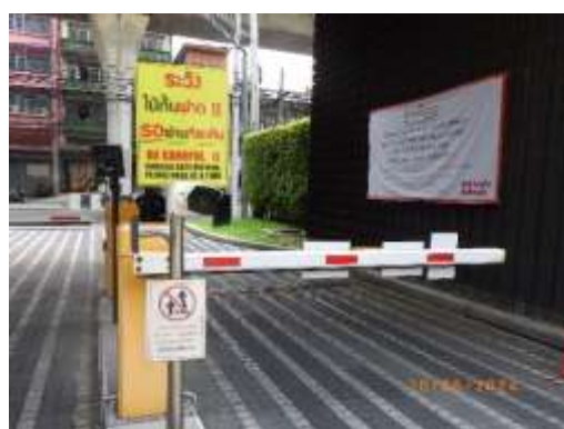
รูปที่ 2-38 Short Range Barrier Gate
