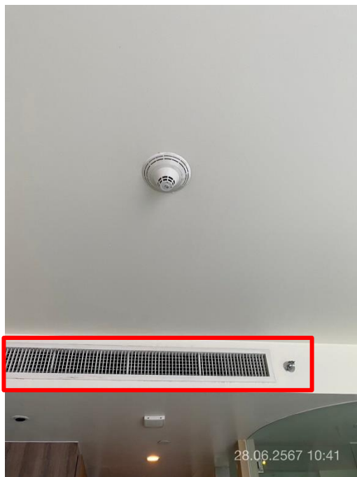
ภาพที่ 17 แสดงช่องเครื่องปรับอากาศและ Sprinkler ภายในห้องพัก
