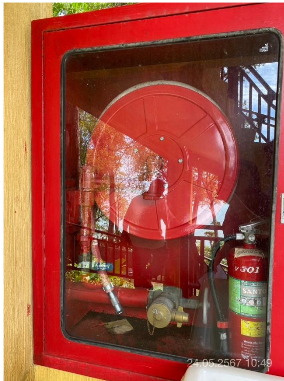
ภาพที่ 10 แสดงตู้จัดเก็บอุปกรณ์ดับเพลิง และหัวรับน้ำดับเพลิง
