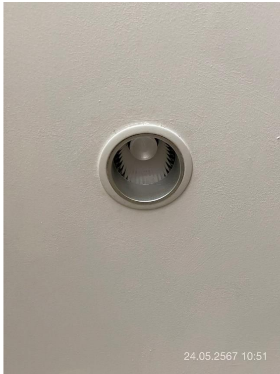
ภาพที่ 5 แสดงหลอดไฟประหยัดพลังงาน (หลอด LED)
