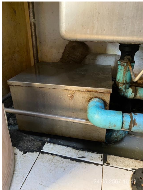
ภาพที่ 30 แสดงถังดับไข้มันเบื่องค์นภายในห้องครัว
