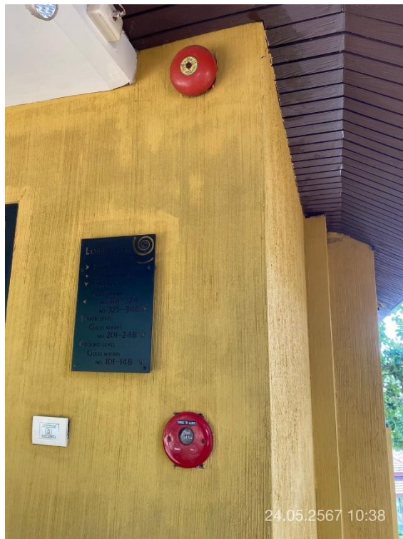
ภาพที่ 14 แสดงระบบสัญญาณเตือนภัย
