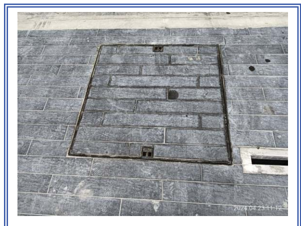
รูปที่ 3.1-15 ป่อพักน้ำทิ้งก่อนระบายออกสู่สาธารณะ (บริเวณถนนรางน้ำ)
