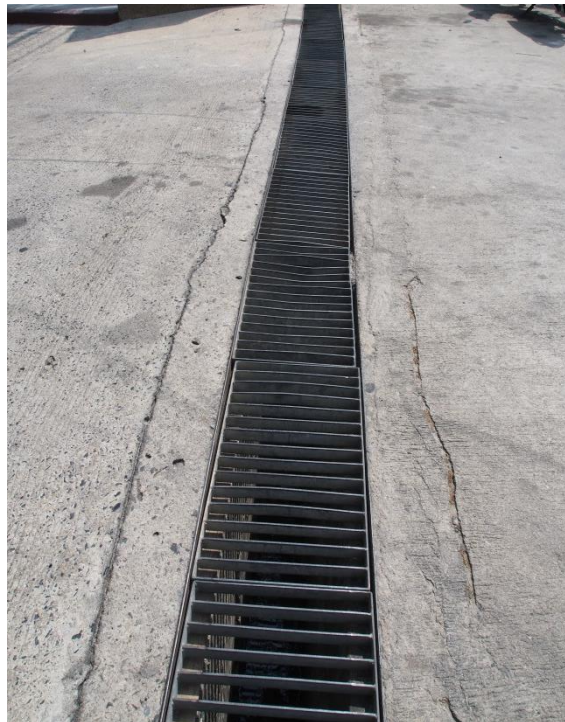
ภาพที่ 18 แสดงรางระบายน้ำ ตะแกรงค้ำขยะ
