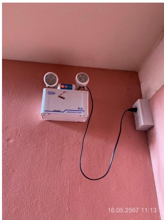
ภาพที่ 12 แสดงเครื่องสำรองไฟฉุกเฉิน
