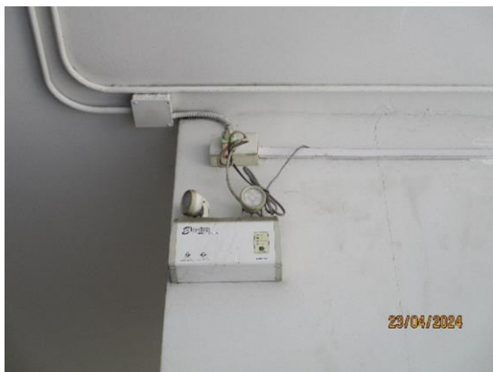
รูปที่ 3.1-39 ไฟส่องสว่างฉุกเฉิน
