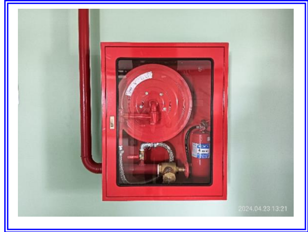
รูปที่ 3.1-33 ตู้เก็บสายฉีดน้ำดับเพลิงพร้อมอุปกรณ์
