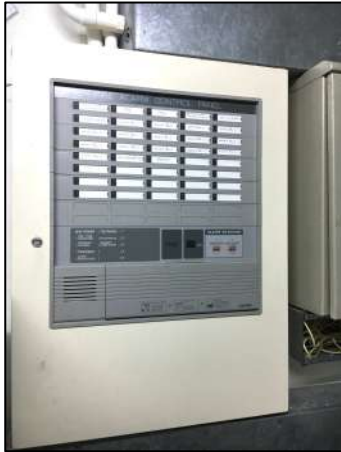
ภาพที่ 1-15 แผงควบคุมระบบสัญญาณ และแผงแสดงสัญญาณแจ้งเหตุเพลิงไหม้
