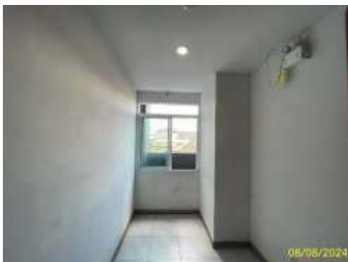
การระบายอากาศบริเวณลิฟต์ดับเพลิง
