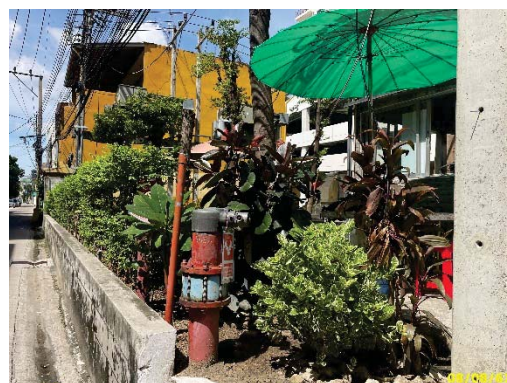
ระบบฉีดน้ำดับเพลิง และหัวรับน้ำดับเพลิง
