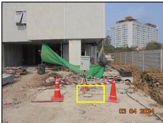
รูปที่ 3.3-1 จุดตรวจวัดความสั่นสะเทือน บริเวณพื้นที่ก่อสร้าง ด้านที่อยู่ใกล้อาคารข้างเคียงมากที่สุด
