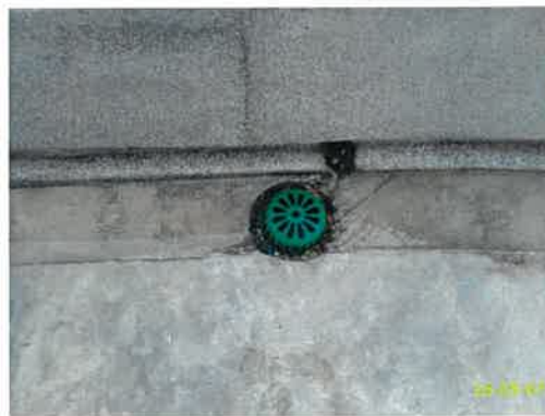
ภาพที่ 2.2-24 ตะแกรงครอบท่อระบายน้ำโครงการ
