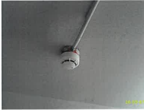
อุปกรณ์ตรวจจับควัน ระบบแจ้งเหตุเพลิงไหม้ (ต่อ)
