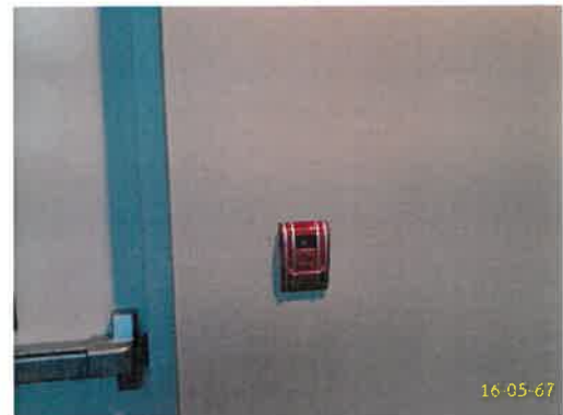
อุปกรณ์แจ้งเหตุเพลิงไหม้แบบใช้มือ
