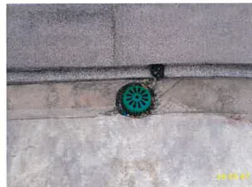
ท่อรับน้ำฝนบนชั้นดาดฟ้า
