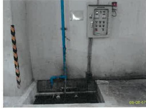
ตู้ควบคุม และบ่อบำบัดน้ำท่วมใต้ดิน ทาวเวอร์ 2
