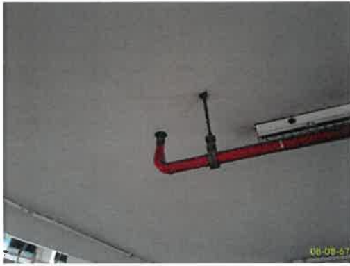
ระบบดับเพลิงอัตโนมัติ (Sprinkler System)
