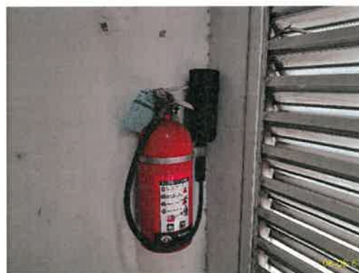
ถังดับเพลิงเคมีแบบมือถือ CO 2
