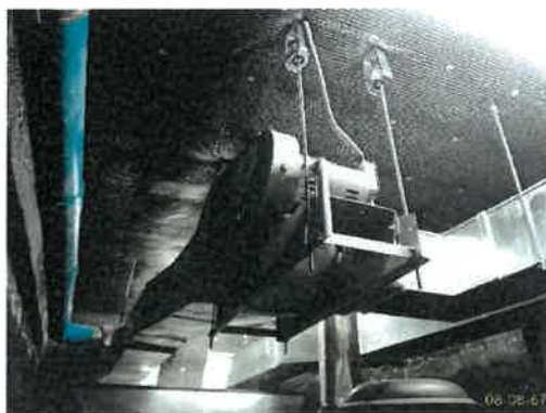
ระบายอากาศชั้นที่จอดรถอัตโนมัติ
