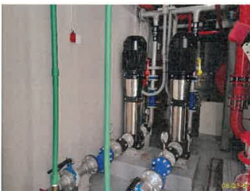
ปั้มน้ำสำรองเพื่ออุปโภค-บริโภคชั้นใต้ดิน
