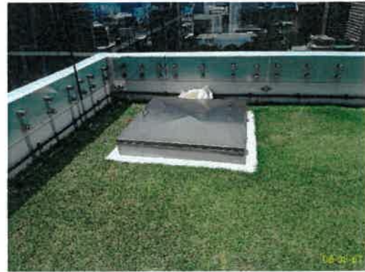
ถังเก็บน้ำสำรองเพื่ออุปโภค-บริโภคชั้นตาดฟ้า
