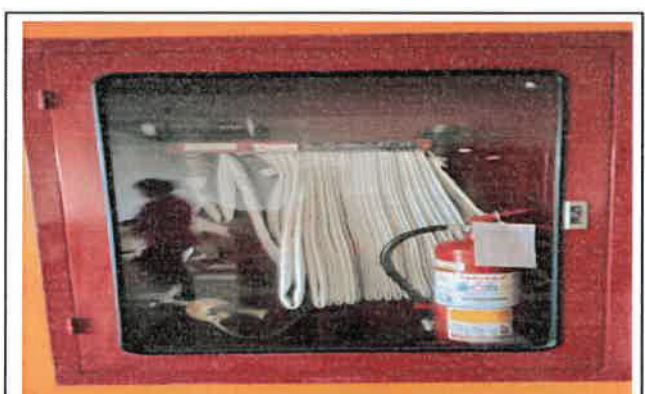
รูปที่ 3.1-12 ตู้เก็บสายฉีดน้ำดับเพลิงพร้อมอุปกรณ์ (FHC)
