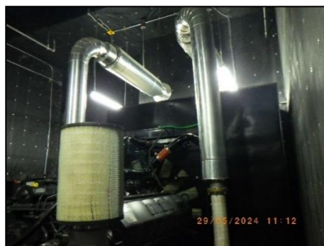
ช่องเปิดระบายไอเสียจากห้องเครื่องกำเนิดไฟฟ้า
