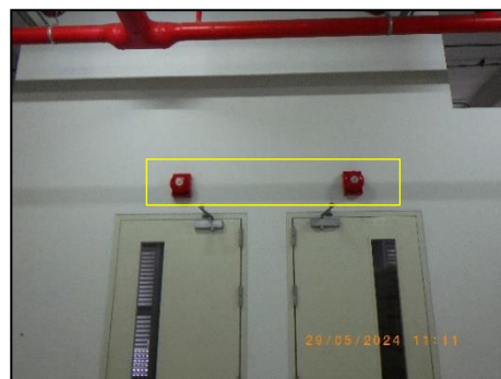
สัญญาณเตือนภัยด้วยเสียง (Fire Alarm Speaker)
