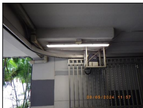
รูปที่ 2-27 การติดตั้งเครื่องปรับระดับแสงสว่าง (Dimmer) และหลอดไฟ
