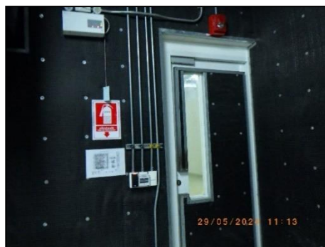
การบุผนัง เพดาน และประตูเหล็กด้วยวัสดุกันเสียง
