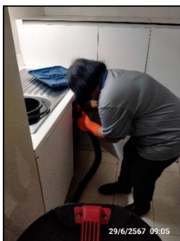
รูปที่ 2-10 การตัดกากไขมันออกจากถังดักไขมัน
