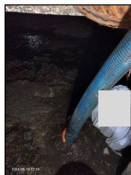
รูปที่ 2-11 การสูบน้ำตะกอนส่วนเกิน
