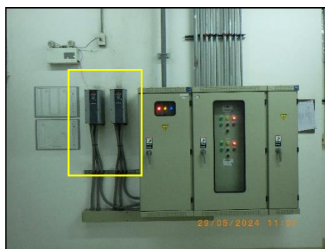
รูปที่ 2-30 อุปกรณ์ปรับความเร็วรอบมอเตอร์ VSD
