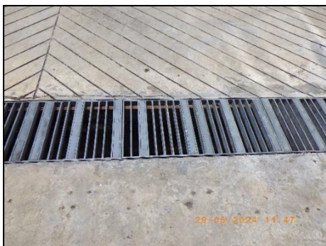
ตะแกรงครอบท่อระบายน้ำภายนอกอาคาร
