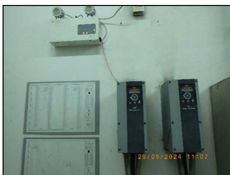
รูปที่ 2-30 อุปกรณ์ปรับความเร็วรอบมอเตอร์ VSD
