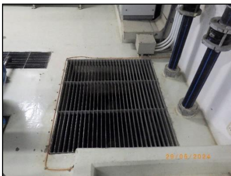
ตะแกรงครอบท่อระบายน้ำภายในอาคาร
