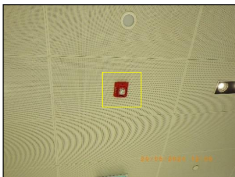
สัญญาณเตือนภัยด้วยเสียง (Fire Alarm Speaker)
