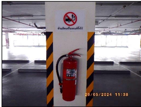
ถังดับเพลิงเคมีแบบมือถือ บริเวณที่จอดรถ
