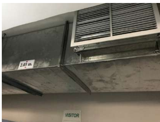
ภาพที่ 2-2 พัดลมดูดอากาศลานจอดรถใต้ดิน
