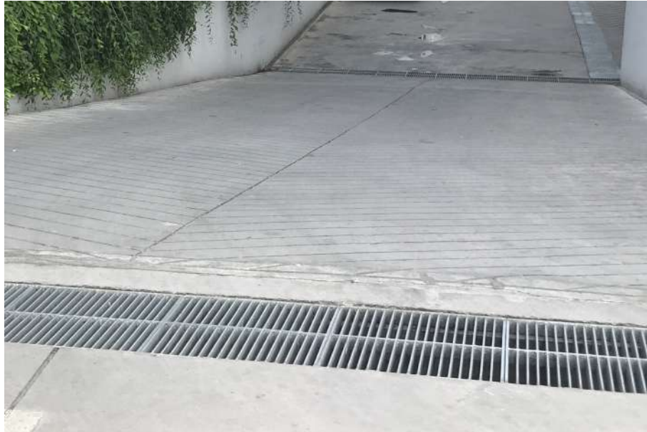
ภาพที่ 1-6 (ข) รางระบายน้ำฝนเข้าสู่บ่อหน่วงน้ำ
