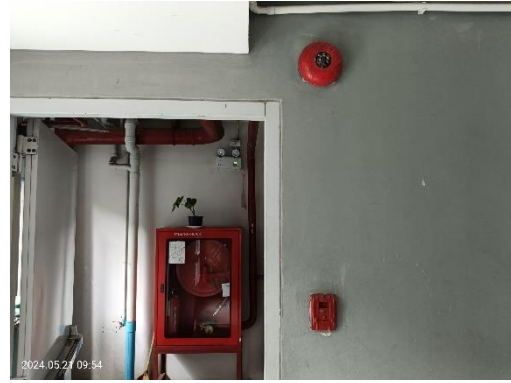
Manual Station และ Alarm bell
