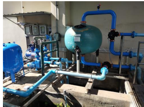
ระบบ Reuse น้ำทิ้งหลังบำบัด
