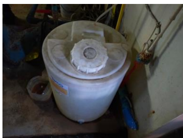
ระบบเติมคลอรีนถังพักน้ำ Under Ground Tank
