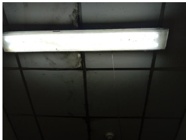
โคมไฟติดแผ่นอลูมิเนียมสะท้อนแสง
