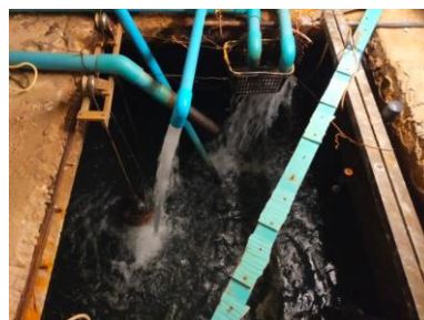
ถังพักน้ำใช้ Under Ground Tank
