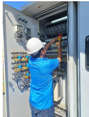
ภาพที่ 2-11 พนักงานตรวจสอบอุปกรณ์ไฟฟ้าที่ระบบบำบัดน้ำเสีย
