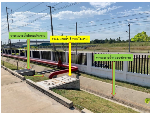
ภาพที่ 2-28 ตัวอย่างรางระบายน้ำเสียและรางระบายน้ำฝนของโรงงาน
