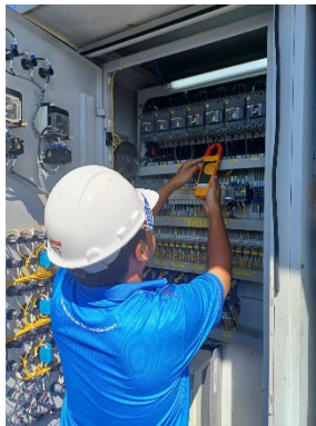
ภาพที่ 2-11 พนักงานตรวจสอบอุปกรณ์ไฟฟ้าที่ระบบบำบัดน้ำเสีย
