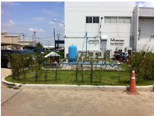
ภาพที่ 2-31 ถังเก็บน้ำดับเพลิงสำรองของโรงงาน
