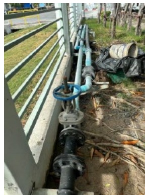
ภาพที่ 2-22 การติดตั้งวาล์วเปิด-ปิด เพื่อควบคุมการปล่อยน้ำเสียของโรงงาน
