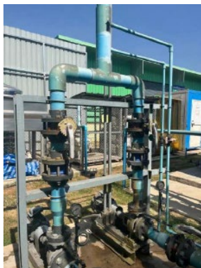
ภาพที่ 2-22 การติดตั้งวาล์วเปิด-ปิด เพื่อควบคุมการปล่อยน้ำเสียของโรงงาน
