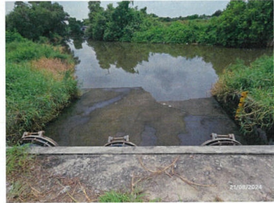
รูปที่ 4 ฝ่ายชะลอน้ำ/คอนกรีตลดแรงกระแทกน้ำ
