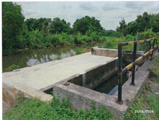
รูปที่ 4 ฝ่ายชะลอน้ำ/คอนกรีตลดแรงกระแทกน้ำ
