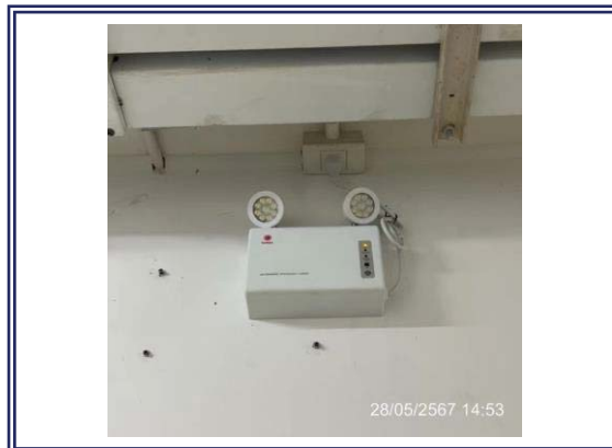
รูปที่ 3.1-53 ไฟส่องสว่างฉุกเฉิน
