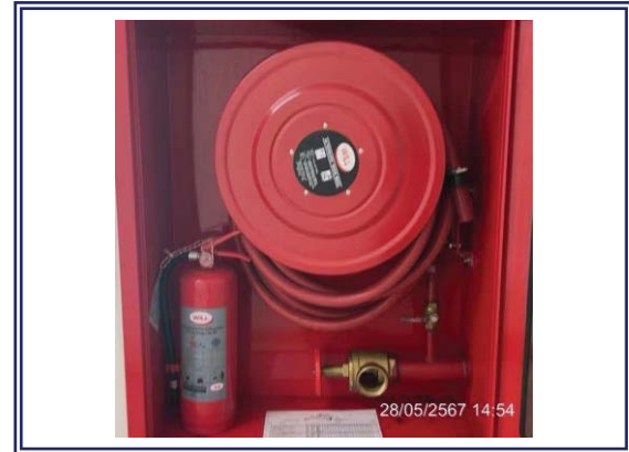
รูปที่ 3.1-52 ถังดับเพลิงแบบมือถือในตู้สายฉีดน้ำ ดับเพลิง
