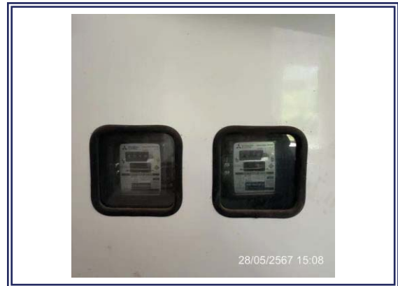
รูปที่ 3.1-22 มิเตอร์ไฟฟ้าของระบบบำบัดน้ำเสีย
