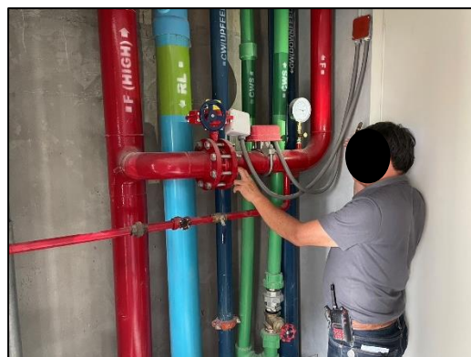
ภาพที่ 19 เจ้าหน้าที่ตรวจสอบรอยรั่วท่อปล่อยน้ำ
