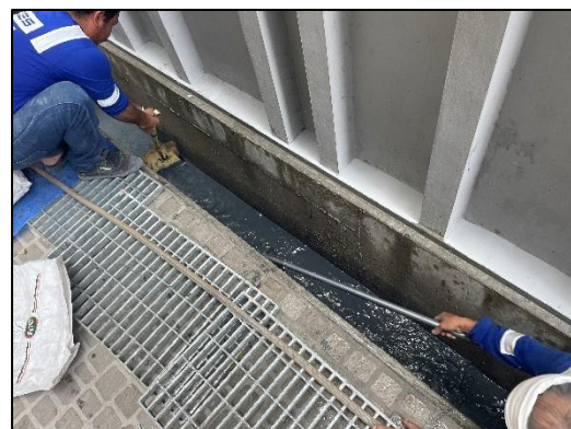
ภาพที่ 47 ขุดลอกตะกอนบริเวณบ่อพักน้ำ
