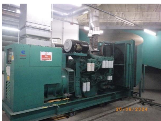
รูปที่ 2-47 ระบบไฟฟ้าสำรอง
