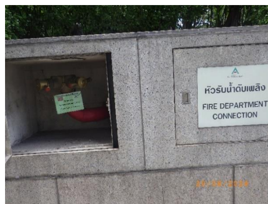
รูปที่ 2-36 ที่เก็บหัวรับน้ำดับเพลิงภายนอกอาคาร
