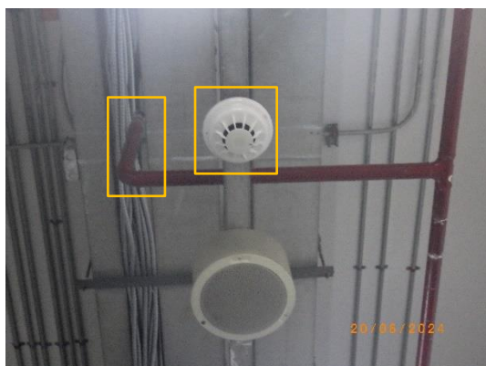
รูปที่ 2-45 หัวกระจายน้ำดับเพลิงและ เครื่องตรวจจับความร้อนภายในอาคาร
