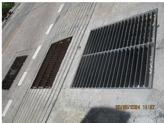
รูปที่ 2-31 ตะแกรงดักมูลฝอย บริเวณทางเข้าโครงการฯ ฝั่งซอยร่วมฤดี
