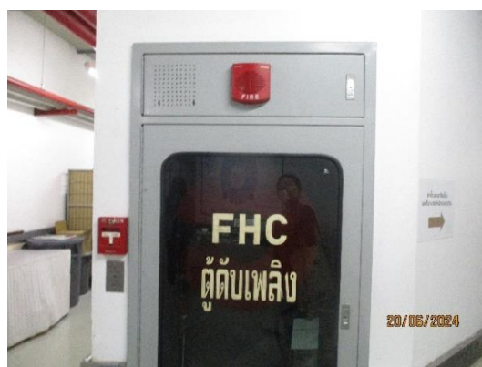
รูปที่ 2-40 ตู้เก็บอุปกรณ์ดับเพลิง และ Fire Alarm
