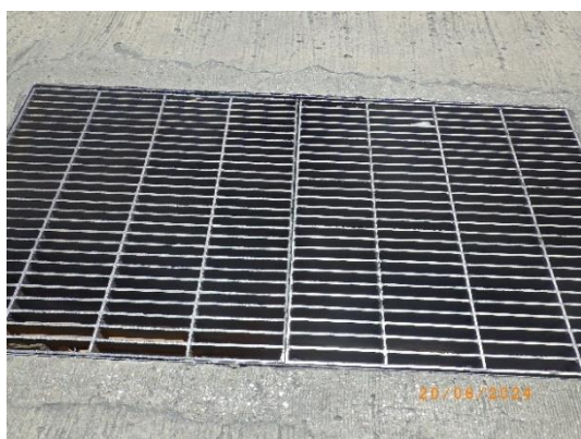
รูปที่ 2-29 ตะแกรงดักมูลฝอยจุดน้ำออก บริเวณทางเข้าโครงการฯ ฟังถนนวิฑู
