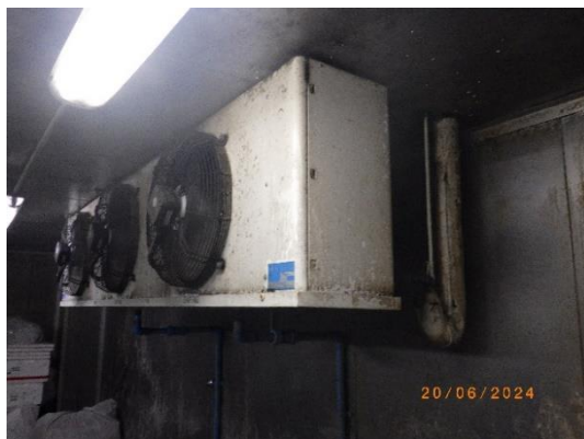
รูปที่ 2-19 ติดตั้งเครื่องปรับอากาศ ภายในห้องพักมูลฝอยเปียก
