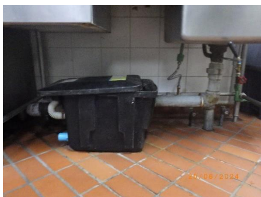
รูปที่ 2-33 ถังดักไขมันสำเร็จรูปภายในห้องครัว
