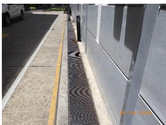
รูปที่ 2-53 รางระบายน้ำภายในโครงการฯ (1)
