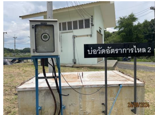
รูปที่ 13 ติดตั้ง Flow Meter
