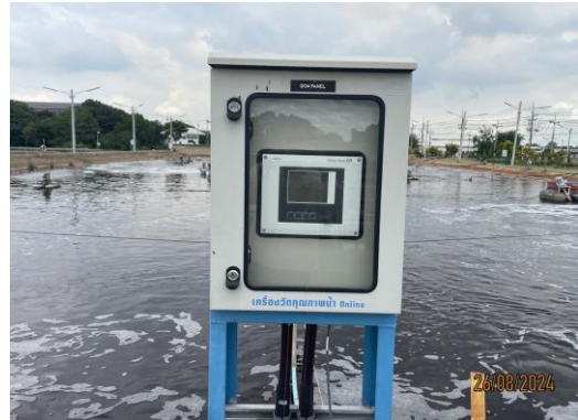
รูปที่ 9 ติดตั้งเครื่องตรวจวัดคุณภาพน้ำ Online
