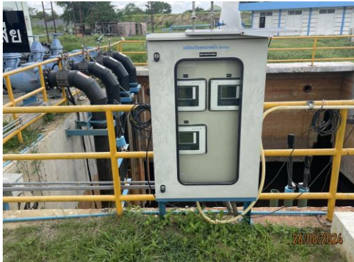
รูปที่ 9 ติดตั้งเครื่องตรวจวัดคุณภาพน้ำ Online
