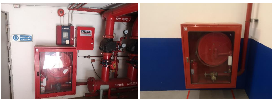
รูปที่ 3-8 ตู้ดับเพลิงและเครื่องดับเพลิงแบบมือถือ
