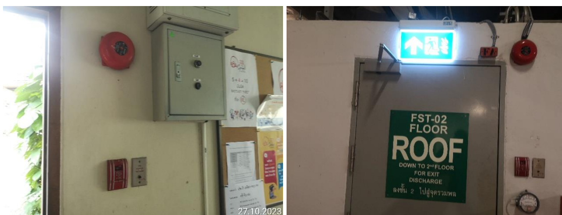
รูปที่ 3-7 อุปกรณ์แจ้งเหตุที่ใช้มือ
