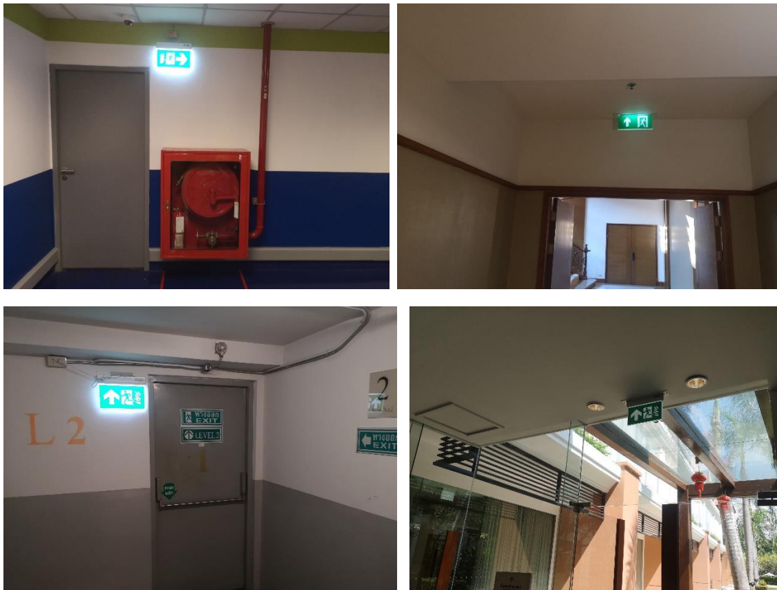
รูปที่ 3-2 ทางหนีไฟ ประตุนิไฟ ป้ายบอกทางหนีไฟ ทางออก
