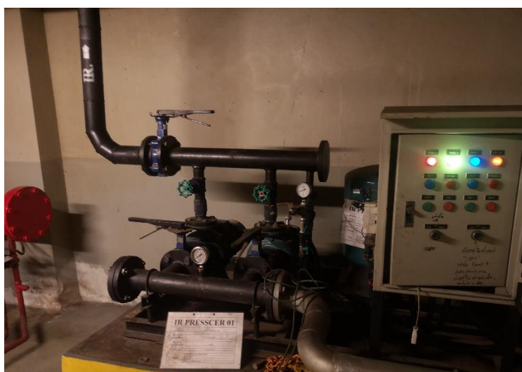
รูปที่ 2-5 เครื่องสูบน้ำหมุนเวียนกลับมาใช้ใหม่และดึงเก็บน้ำหมุนเวียนกลับมาใช้ใหม่
