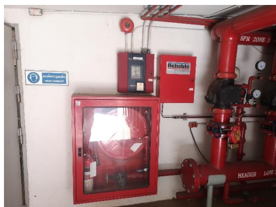
รูปที่ 3-5 การติดตั้งระบบแจ้งเหตุเพลิงไหม้ ตู้ดับเพลิงและอุปกรณ์ดับเพลิง
