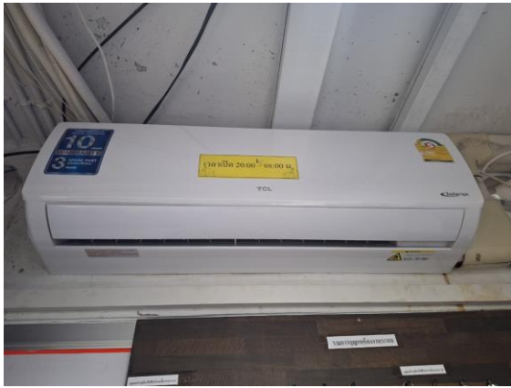
รูปที่ 2-31 ระบบปรับอากาศที่มีฉลากประหยัดไฟเบอร์ 5
