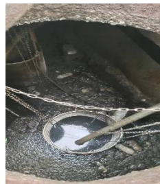
ดูแล ตรวจสอบระบบบำบัดน้ำเสีย โดยตัดไขมัน และสับกากตะกอนจากบ่อบำบัดน้ำเสียเป็นประจำสม่ำเสมอ
