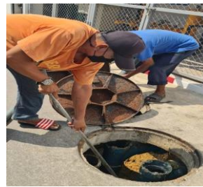
ดูแล ตรวจสอบระบบบำบัดน้ำเสีย โดยตัดไขมัน และสับกากตะกอนจากบ่อบำบัดน้ำเสียเป็นประจำสม่ำเสมอ
