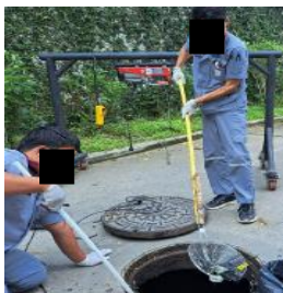
ดูแล ตรวจสอบระบบบำบัดน้ำเสีย โดยตัดไขมัน และสับกากตะกอนจากบ่อบำบัดน้ำเสียเป็นประจำสม่ำเสมอ
