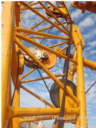
ภาพที่ 5-27 ตรวจสอบอุปกรณ์ปั้นจั่น ให้ความสมบูรณ์ก่อนเริ่มการทำงาน
