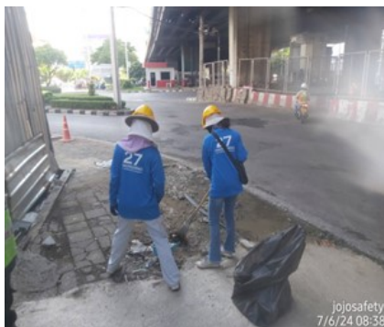
ภาพที่ 5-21 ขุดลอกท่อระบายน้ำหลังจากการเสาะเข็มแล้วเสร็จ
