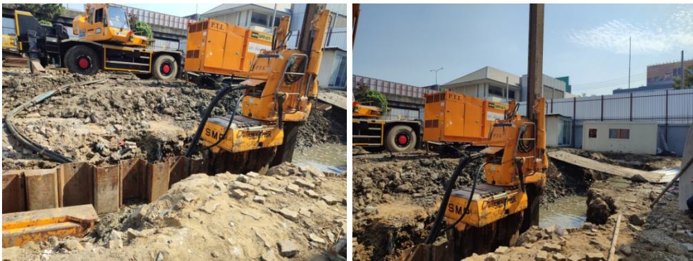
ภาพที่ 5-12 ทำเสาเข็มแบบเจาะ ชนิดเปียก และกด Sheet Pile
